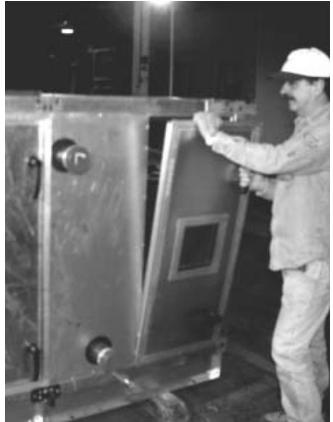
FIG. 3 - REMOVE DOOR ASSEMBLIES
