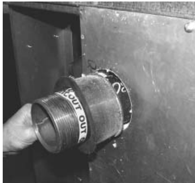
FIG. 15 - REMOVE GROMMET(S)
